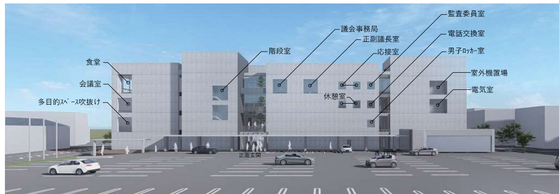
北側からのパース
