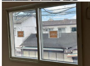
主居室の南側に内窓設置
