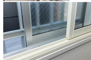
全住戸の内窓設置を実施
