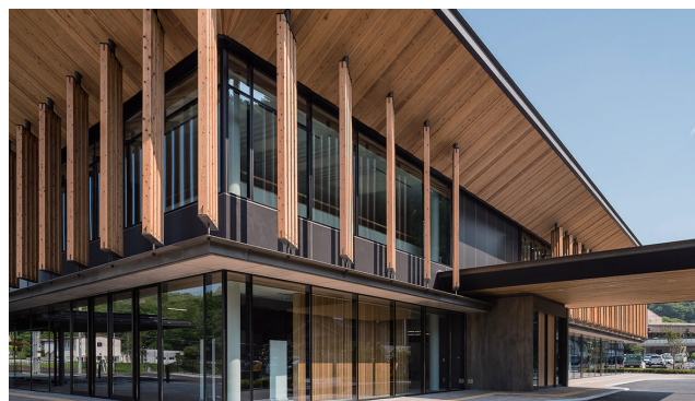
ルーバー、庇の例（五ヶ瀬町役場新庁舎）
