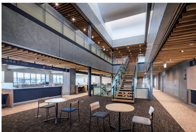
天井の木質化の事例（島田市庁舎）
