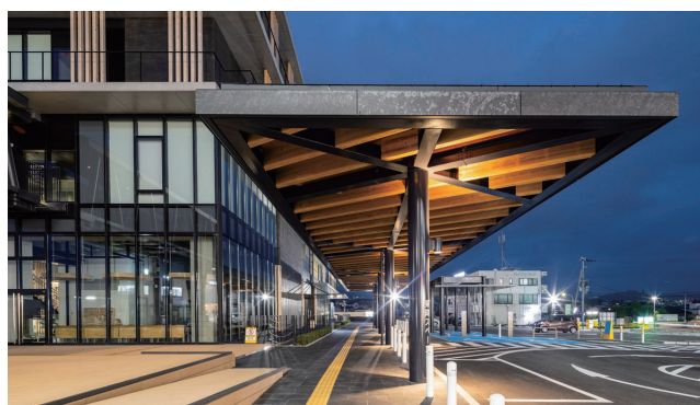
庇のある駐車スペースの例（田辺市庁舎）
