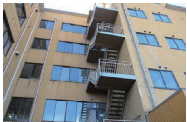
鉄骨外部階段
