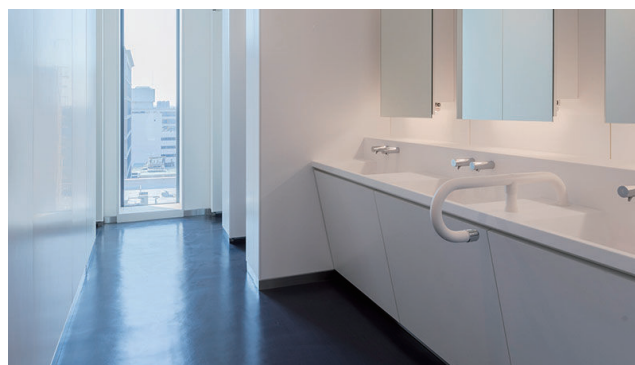
清掃のしやすい床仕上げ材の例（神奈川県東庁舎）
