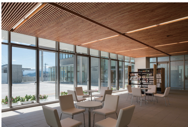
天井の木質化の事例（観音寺市庁舎）
