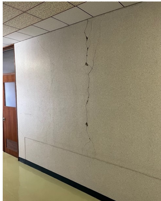
←壁面の亀裂
