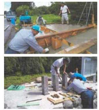
○生コン打設工事(上) ○石碑設置工事(下)
