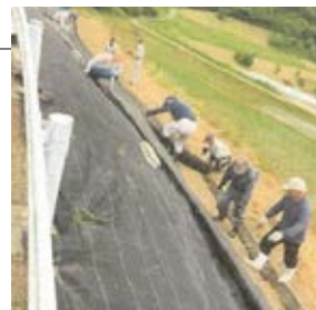
○除草シート整備
