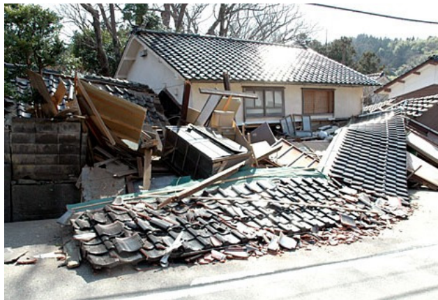
能登半島地震により一部道路を塞いだ建物 (輪島市門前町地内)
