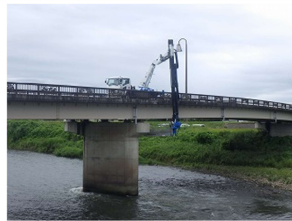
(橋梁下面の点検状況)
