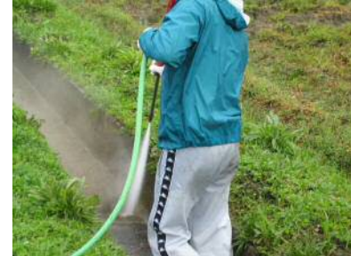
高圧洗浄機による 水路内の清掃
