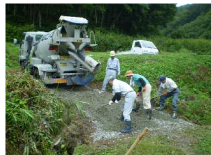
コンクリート舗装状況
