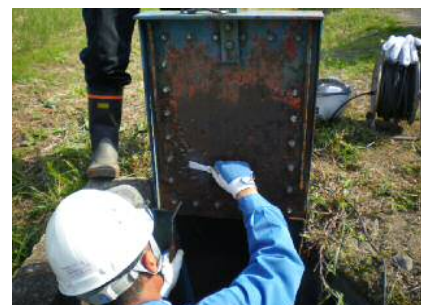
ゲートの補修状況
