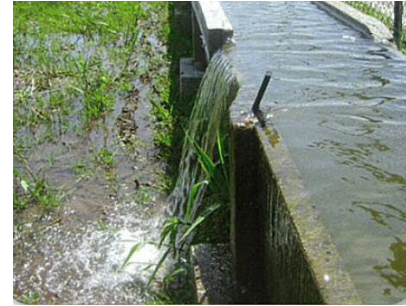
水路からの部分的な溢水
