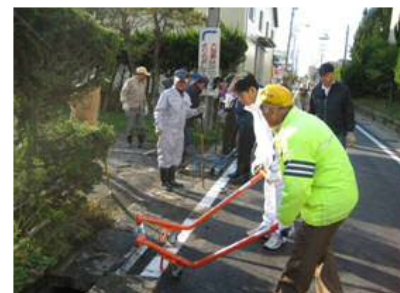
水路蓋の設置 (専用器具使用)
