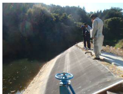
遮水シートの設置
