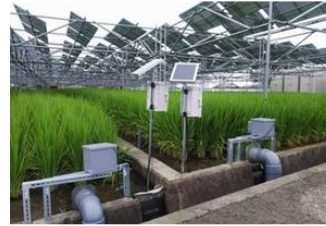
図表 5-68 営農型太陽光発電の導入例
