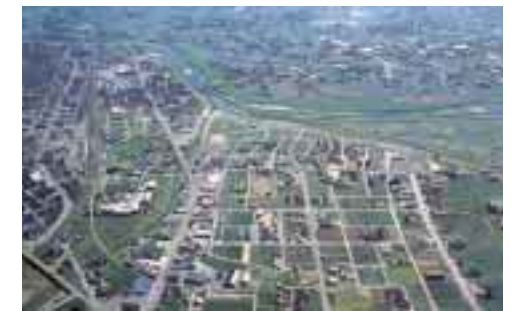
駅南第2土地区画整理
