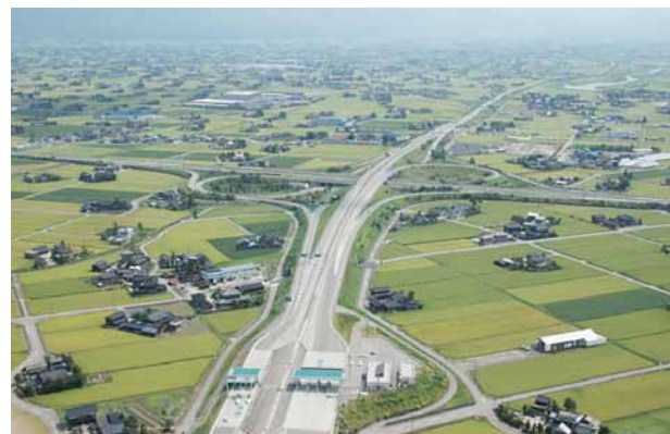
東海北陸自動車道
