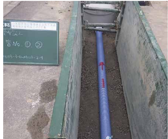
下水道管の布設
