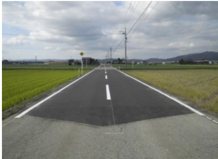
市道石名田七社線舗装補修(道明地内)
