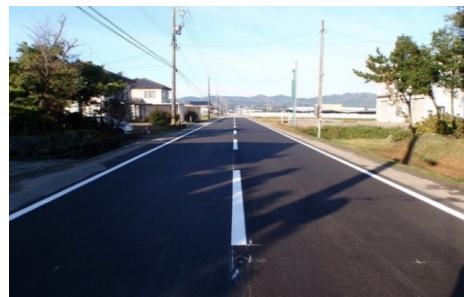
市道平田下中線（舗装補修）
