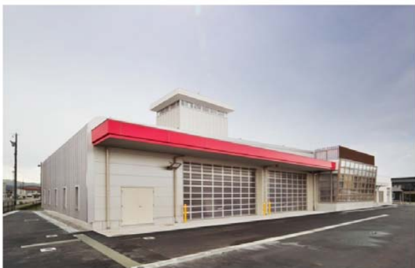
小矢部消防署津沢出張所
