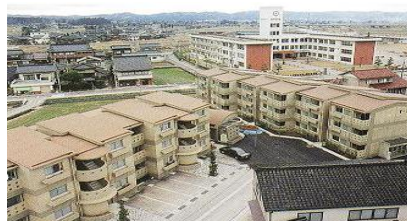
津沢第3住宅 (公営)
