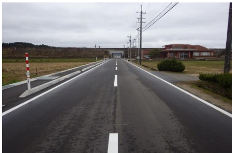
市道藤森小森谷線(道路改築)
