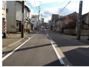
市道新富町桜町線(舗装補修)
