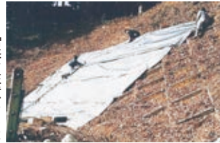
▶足下注意しろよー!「はい!」みんなで防草シート張り。
