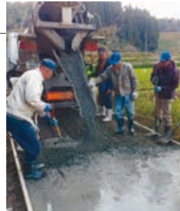
生コン舗装中
