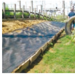
盛り土をして防草シート張り
