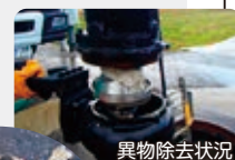
異物除去状況
