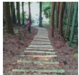
135段の階段が完成!
