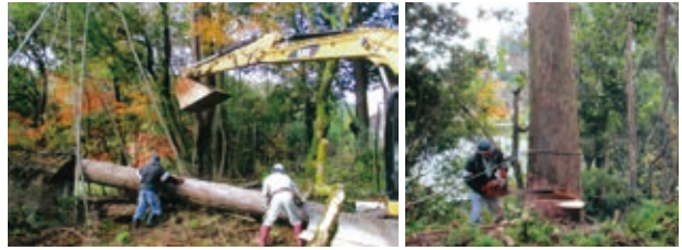
慎重に作業を進めて、伐採しました。
