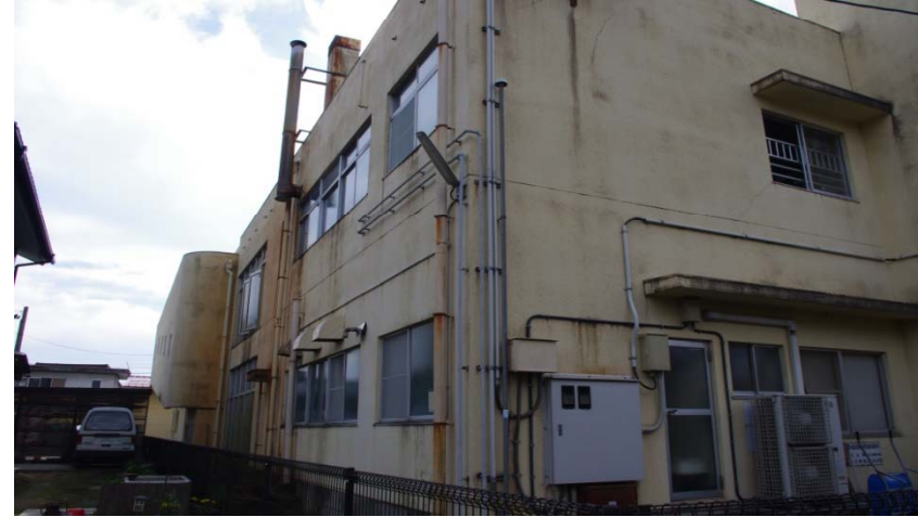
耐震補強箇所
