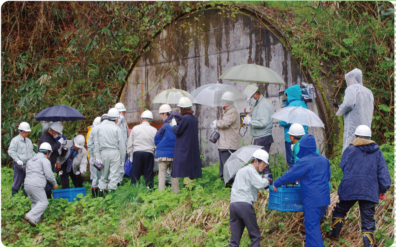
「加越トンネル」の現地調査 平成22年4月27日に沼田議長をはじめ市議会議員が、「加越トンネル」(名ヶ滝地内)を現地調査しました。
