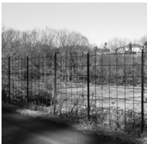
恒久的な侵入防止柵 (金網フェンス)
