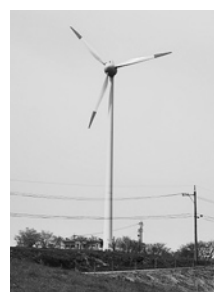
稲葉山にある風力発電設備
