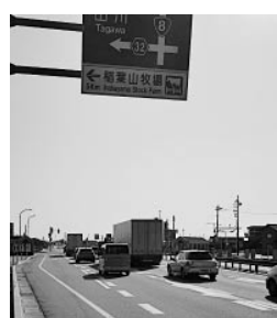
4車線化された国道8号
