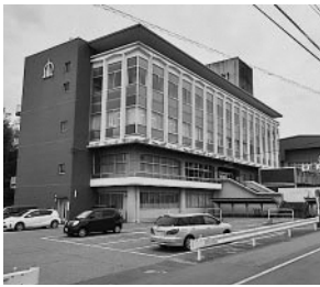
平成32年の供用開始を目指し、（仮称）石動コミュニティプラザの整備計画が進められている
