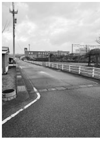
石動駅南の防犯灯未設置箇所
