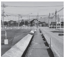
拡幅工事が進む主要地方道 砺波小矢部線
