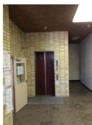
2階エレベーター口
