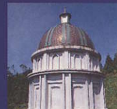
㉑ 殖生高区配水池
