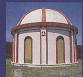
㉒ 城山配水池
