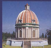
⑳ 蟹谷配水池
